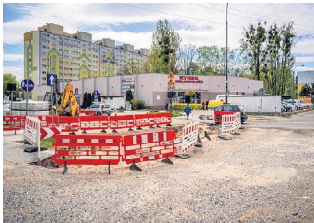
Prace na Wielkopolskiej przyspieszą po zakończeniu wymiany instalacji podziemnych
