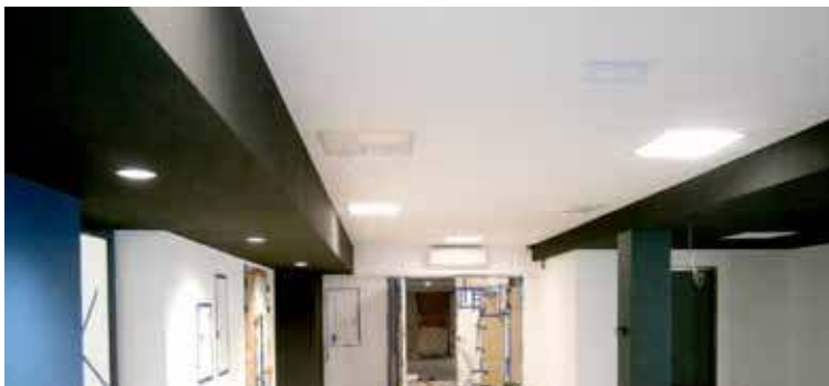
Nadal trwają prace m.in. w zakresie instalacji elektrycznej, teletechnicznej i sanitarnej
