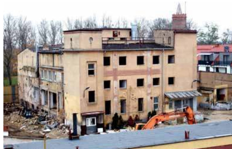
Poddany rozbiórce budynek po dawnej Spółdzielni Mleczarskiej na ul. Chrobrego, gdzie były produkowane słynne lody Bambino. Zdjęcia Sławek Alex
