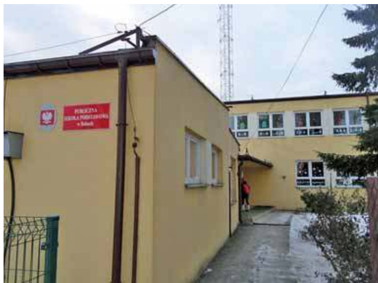
Do szkoły w Bobach jako filii PSP nr 1 (tu budynek przed termomodernizacją) uczęszczają dzieci z klas I-III i przedszkolaki
