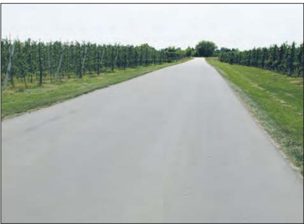
Trwa wieloletnia batalia o uregulowanie stanu prawnego prywatnych gruntów zajętych pod drogę gminną w miejscowości Wicie (gm. Wilga). Nic nie wskazuje na to, żeby szybko się zakończyła
