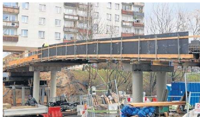
Trwają intensywne prace przy budowie nowej kładki pieszo-rowerowej nad ulicą Sandomierską na Ustroniu.
