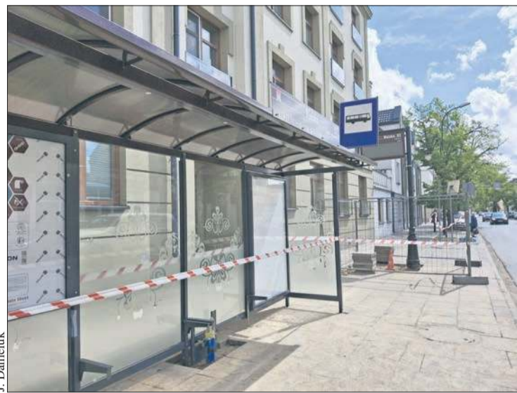
Przystanek autobusowy przy ul. Sienkiewicza 46
