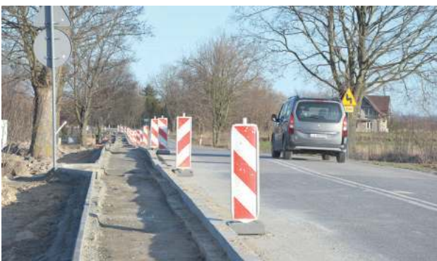
Budowa chodnika ruszyła na początku lutego. Wykonawca z pracami musi zdążyć do czerwca
