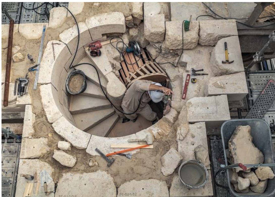
Kamieniarz używa pneumatycznego dłuta, aby starannie wyprofilować spiralne schody, które będą prowadzić w górę wieży.
