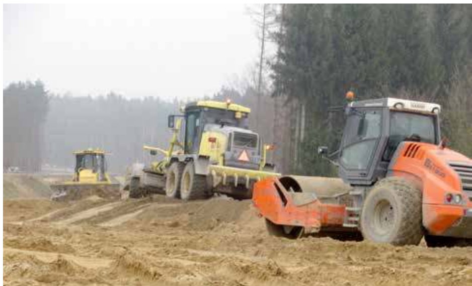
Wraz z poprawą pogody ostro ruszyły roboty na budowie obwodnicy Gryfina
