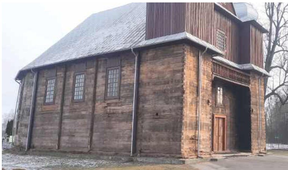
Ruszyły prace na zewnątrz świątyni
