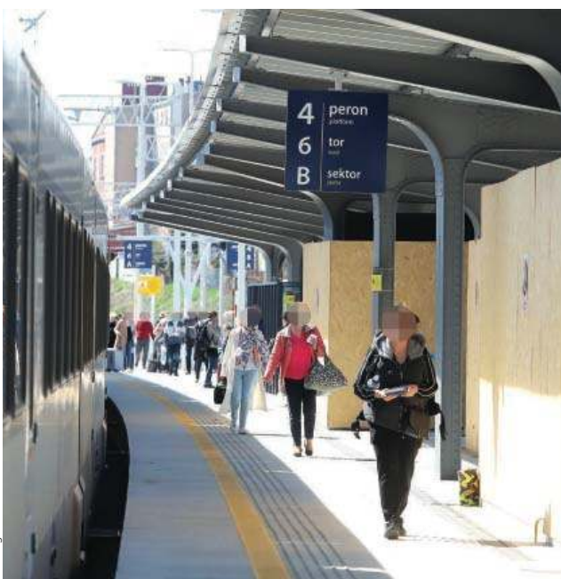
Po peronie 4. wyremontowane zostaną pozostałe trzy perony
