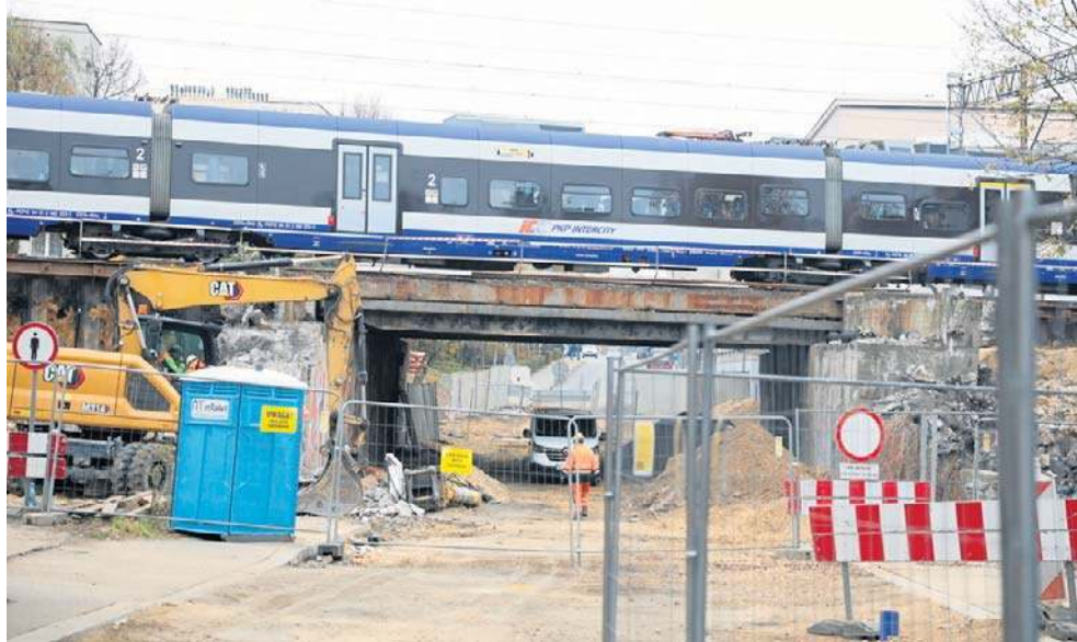
Prace zmierzają do końca. Nowy wiadukt będzie miał większy prześwit między drogą a obiektem, co wyeliminuje ograniczenie wysokości dla samochodów
