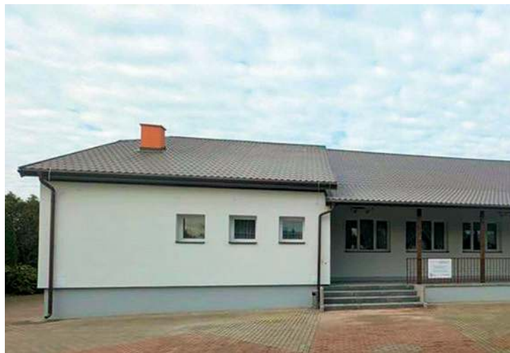
Świetlica, po remoncie, jak nowa
