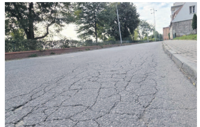
Ulica Rybacka w Oławie pójdzie do remontu
