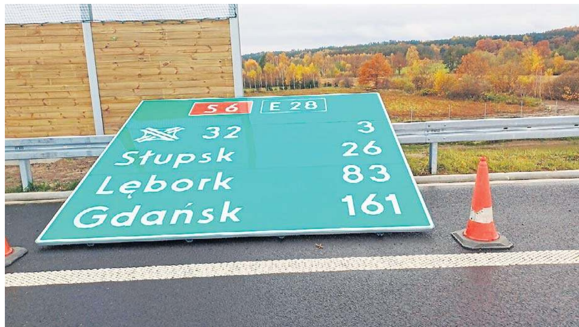
Na wielu odcinkach budowanej trasy S6 trwa już montaż znaków drogowych i tablic informacyjnych
