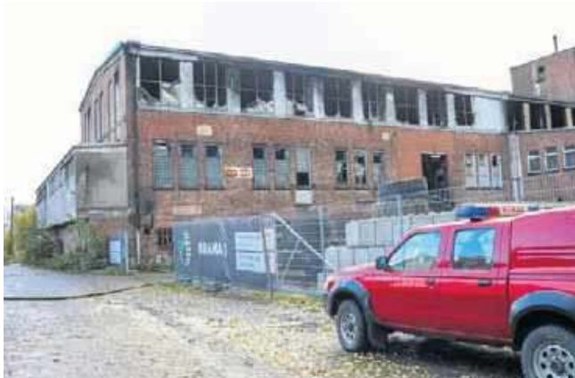
W zabytkowym budynku byłej papierni działała firma zajmująca się przetwórstwem starych opon
