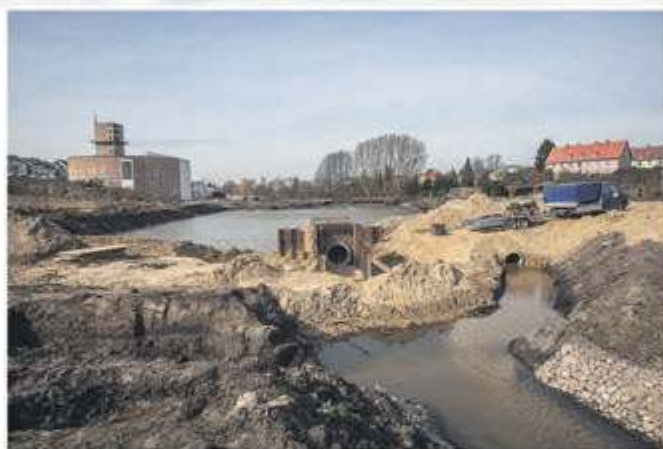
Rozbudowa zbiornika retencyjnego „Fatimska”
