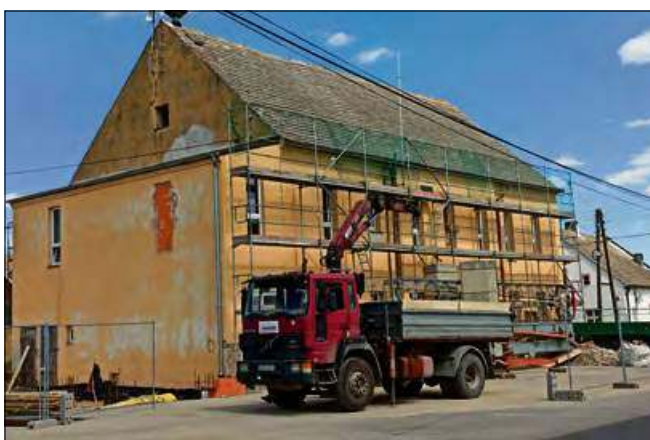
W Raławiczkach trwają prace nad przygotowaniem do rozbiórki dachu domu kultury.
