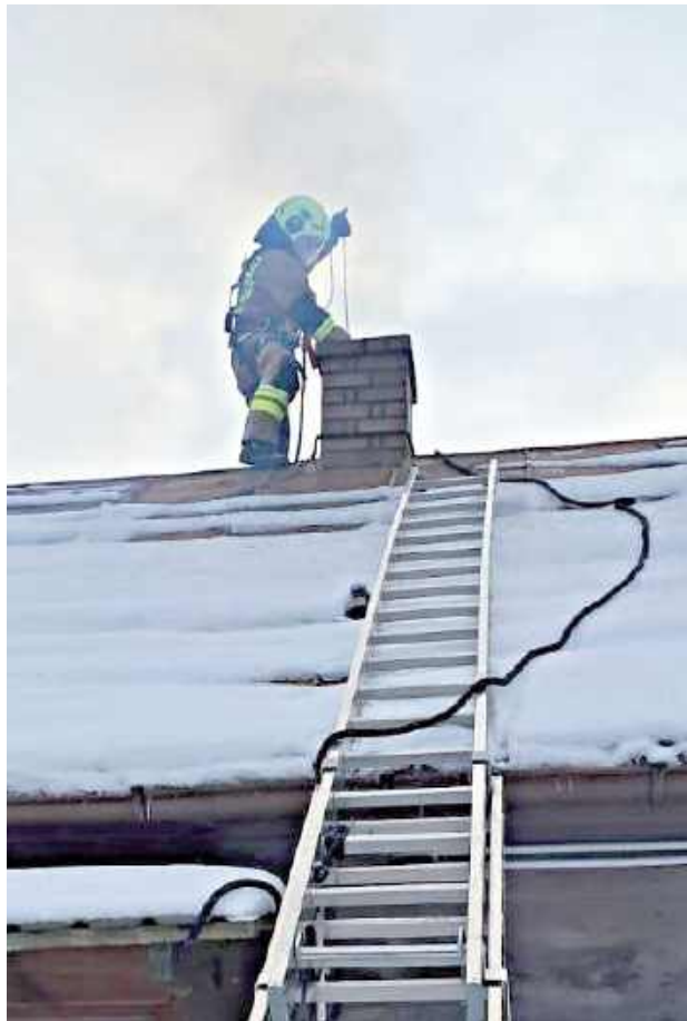
Prawo budowlane zobowiązuje do corocznej kontroli stanu technicznego instalacji gazowych oraz przewodów kominowych
