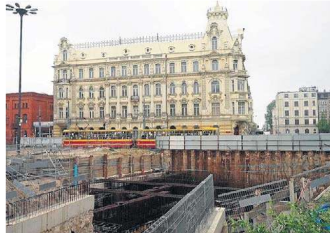
Tak obecnie wygląda niedokończona, a właściwie rozgrzebana budowa przystanku Łódź Śródmieście
