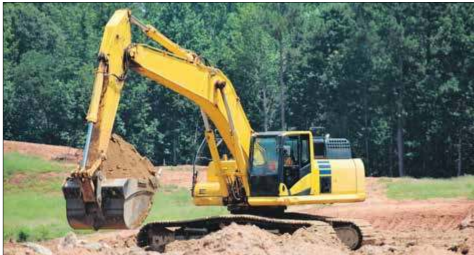
Kosztorys inwestorski pozwala zaplanować wszystkie prace, od wykonania fundamentów, po stan deweloperski
