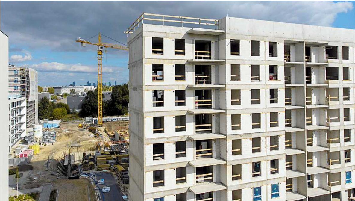
• Budowa nowych osiedli w warszawskim Ursusie, wrzesień 2021 r. FOT. MACIEK JĄZWIECKI / AGENCJA GAZETA
