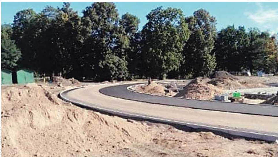
Stadion Miejski w Pisz z każdym dniem nabiera kształtu — trwa asfaltowanie
