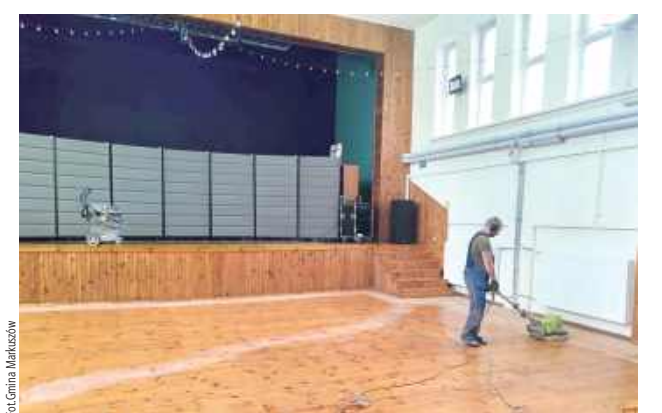
Renowację przeszła m. in. podłoga, scena i inne drewniane elementy wystroju sali widowiskowej
