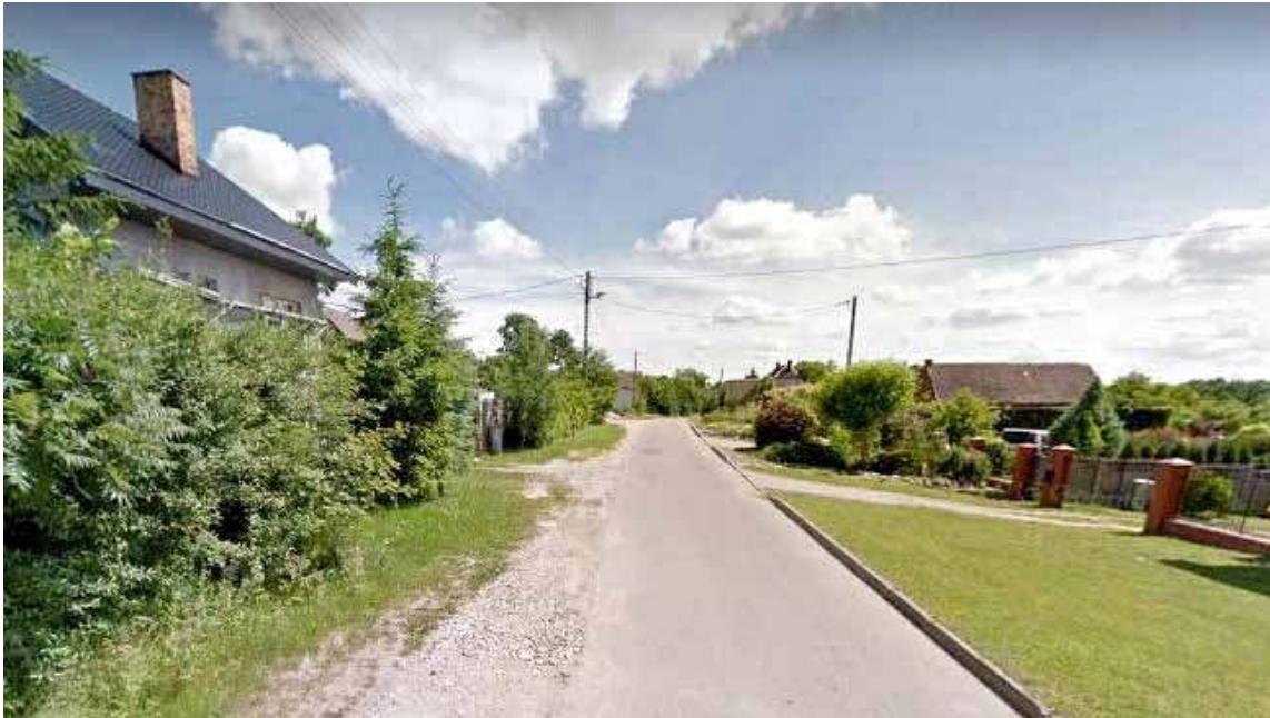
Ze Stargardu do Klępina prowadzi wąska droga z licznymi ubytkami i zniszczonym poboczem. Foto. arch
