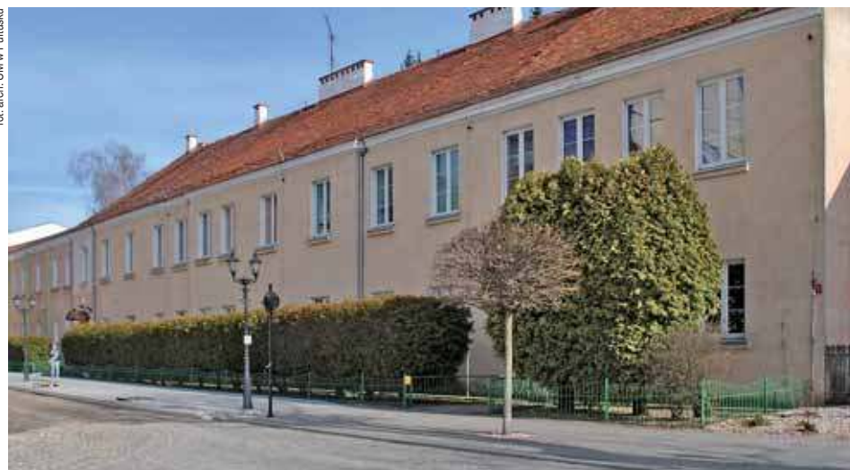
Zabytkowy budynek dawnego Seminarium Duchownego w Pułtuskach przechodzi gruntowną modernizację. Samorząd województwa mazowieckiego przeznaczył na ten cel w sumie ponad 3,7 mln zł
