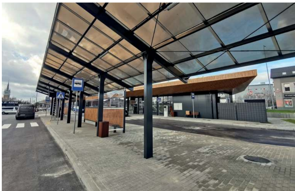
Jeden z peronów autobusowych w centrum przesiadkowym w Trzebinie
