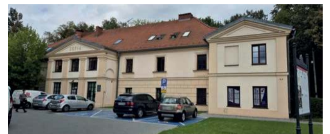
Zabytkowy budynek „Zofia” Małopolskiego Szpitala Rehabilitacyjnego przed modernizacją
