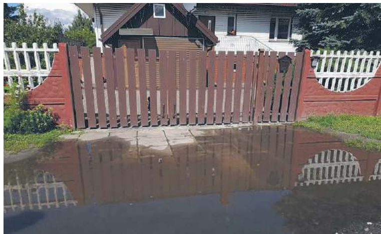
Zdjęcia zrobione dzień po ulewie. Jak mówi nasz Czytelnik, część wody zdążyła już odparować, ale poprzedniego dnia woda z ulicy wpływała na jego posesję.
