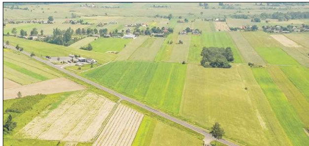
Przygotowywany do budowy odcinek Via Carpatii między Radzynie i Kockiem to dwujezdniowa trasa ekspresowa, która powstanie w istniejącym korytarzu drogi krajowej nr 19
