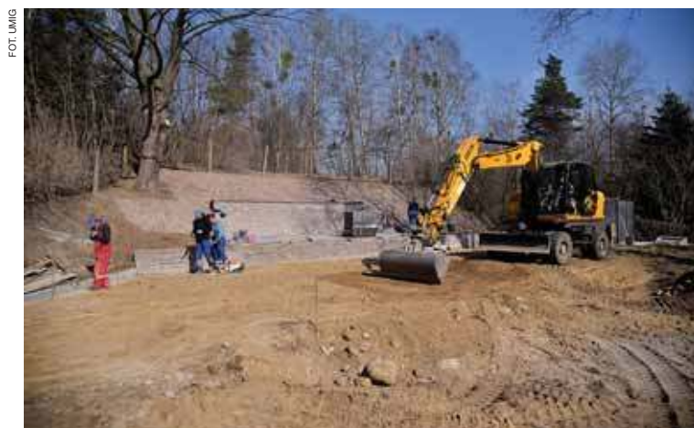
Budowa sceny plenerowej w Klonowie
