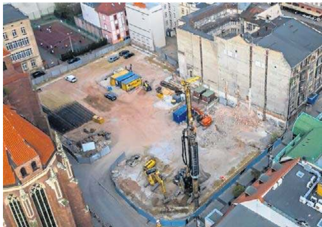
Rozpoczęły się prace budowlane w miejscu wyburzonego Solpolu. Z lewej widoczny kościół
