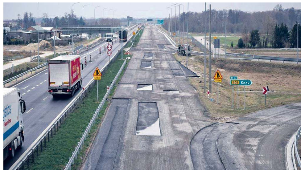
Budowa S19 – druga jezdnia obwodnicy
