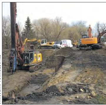
W rejonie ul. Wańkowicza powstaje instalacja służąca odwodnieniu terenu stadionu
