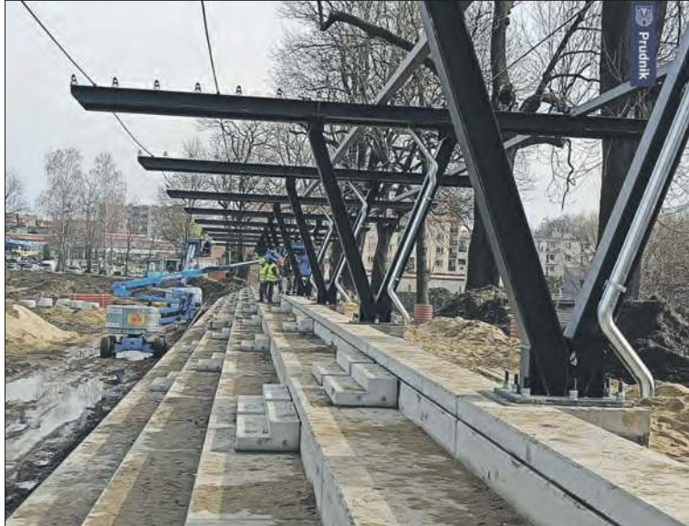
Konstrukcja zadaszenia nad trybunami już jest
