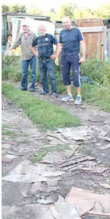
Prowizoryczna droga, jaką mieszkańcy bloków 91 A i B zrobili by dojeżdżać na swoje podwórko
