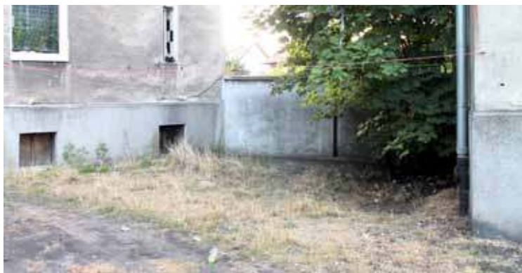
To właśnie tutaj ma przebiegać droga dojazdowa. Mur i znajdująca się za nim działka znikną a przebiegać będzie tutaj droga, na co z niecierpliwością czekają mieszkańcy
