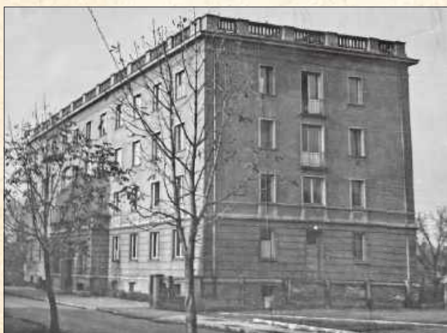
■ Hotel robotniczy przy ulicy Bukowej
