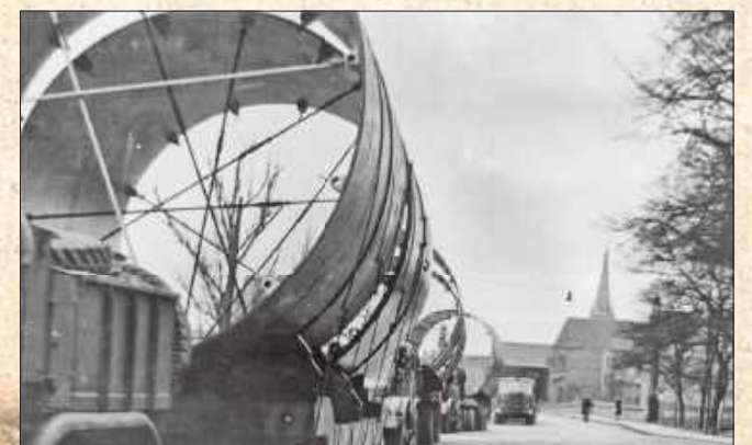
■ Transport drogowy części pieca cementowego dla Węgierskiej Republiki Ludowej
