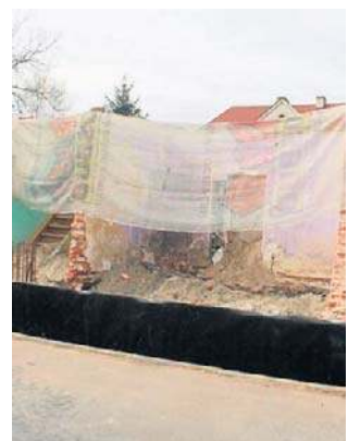
Budynek został niemal w całości rozebrany.
