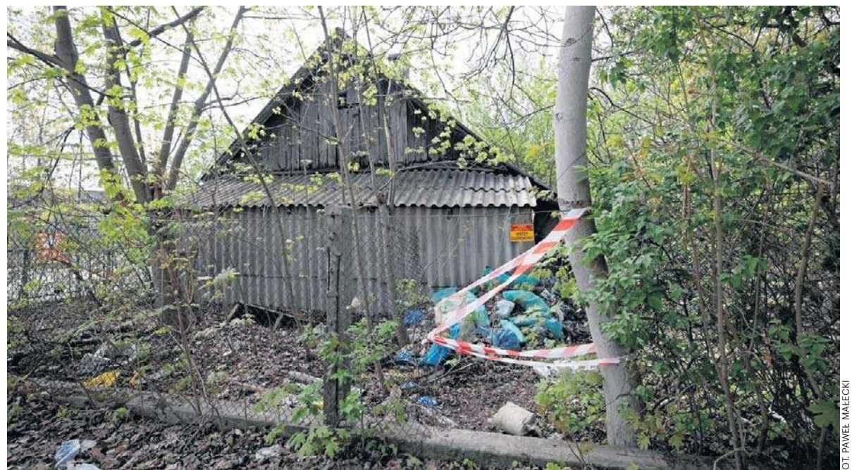
W czwartek strażnicy miejscy z kieleckiej sekcji ekologicznej kontrolowali pustostany przy ulicy Górnej
