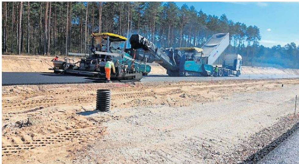
Trwa budowa ekspresowej S74 Mniów - Kielce. Właśnie ruszyły roboty bitumiczne na dwujezdniowej trasie głównej
