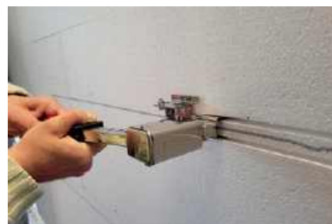
📌 Rowki w starannie wyznaczonych miejscach najłatwiej jest wykonać specjalnymi narzędziami. BELLA PLAST
