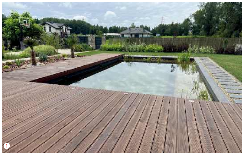
➦ W 2023 r. przed frontem domu, skierowanym w stronę południa, zbudowano staw kąpielowy. Pomosty – każdy o powierzchni 2,5 x 10 m, wykonane z ryflowanych desek z modrzewia europejskiego – połączono z identyczną podłogą zadaszonego tarasu, który postawiono w trakcie budowy domu. Dwa dwumetrowe szorstkowce Fortune'a ozdabiają kąpielisko.
