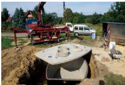
➋ Szczelne szambo to najczęstszy wybór, gdy dom nie ma dostępu do kanalizacji. PROBUD
