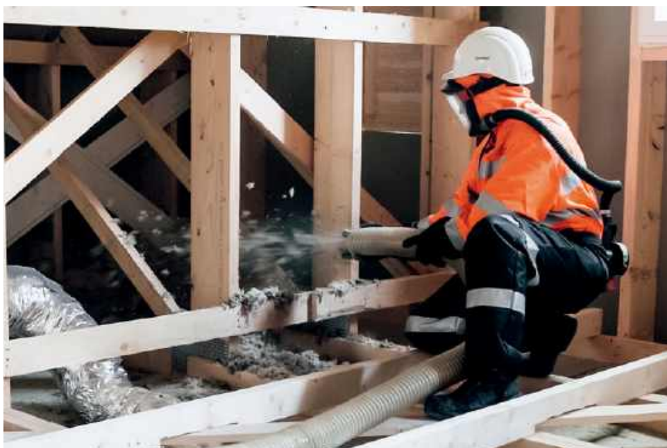
Wdmuchiwanie pod ciśnieniem wełny w granulacie. PAROC
