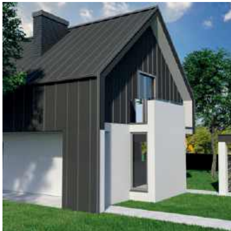
❷ Już samo „zagranie” kolorem zmieniło wygląd budynku. Efekt wzmacniają jednak boniowania, stanowiące niejako przedłużenie innych wyraźnych linii. BELLA PLAST
