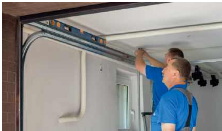
🔧 Bramę garażową montuje się w wykończonym wnętrzu. NOVOFERM
