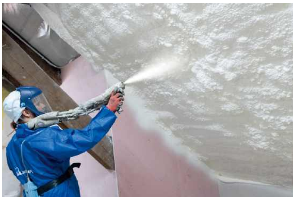
Ocieplanie dachu skośnego pianką poliuretanową metodą natryskową. ULTRAPUR
