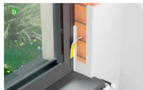
❸ Specjalne przyokienne listwy dylatacyjne warto zastosować zarówno od strony zewnętrznej (a), jak i w pomieszczeniu (b).
