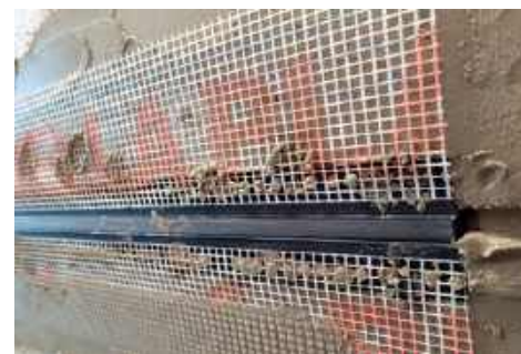
📌 Listwę systemową wciska się w wyfrezowany rowek wypełniony klejem. Na tym etapie listwa jest jeszcze zamkniętym profilem. BELLA PLAST
