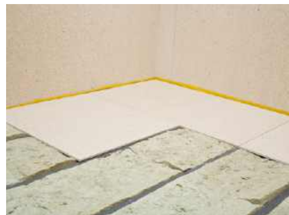
Podłoga ocieplona wełną mineralną. Kolejna warstwa to płyty suchego jastrychu, który stanowi podkład pod materiał posadzkowy. WOODECO
