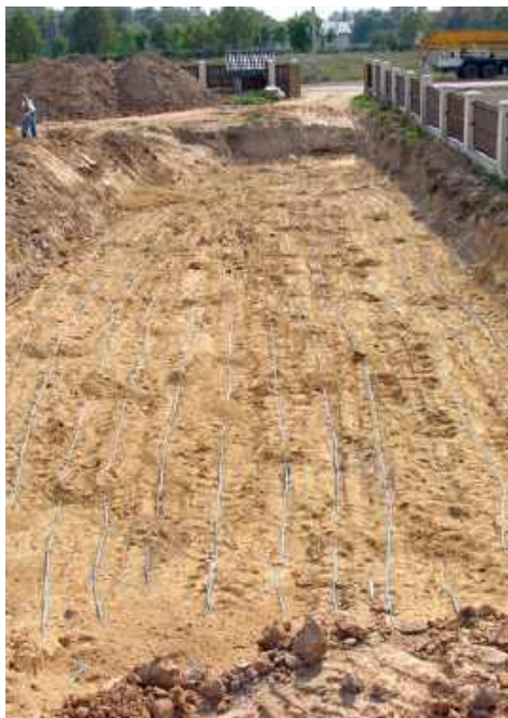
🔧 Technicznie wykonanie kolektora poziomego nie jest trudne. Jednak wchodzi w grę tylko na dużych działkach. CLIMA KOMFORT
