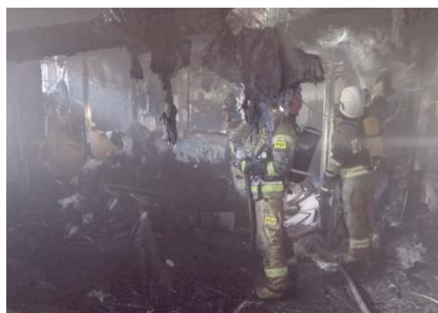
Spłonęło ok. 100 metrów kwadratowych powierzchni sklepu, przyczyna pożaru na razie nie jest znana (fot. PSP Łuków)
