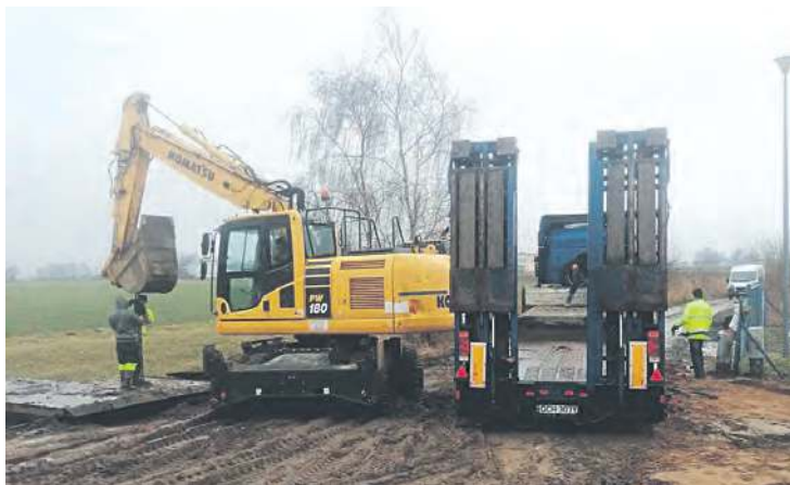
W Kęsowie trwa już przebudowa największej przepompowni ścieków.
