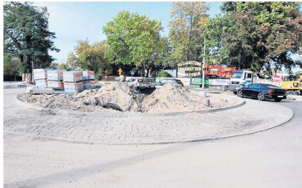
Pojutrze ma zostać otwarty zostanie również wyjazd z ronda w ul. Siewną w kierunku centrum miasta
