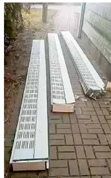
Uszkodzone elementy barierki umieszczonej wzdłuż starej 6 w wyniku działania wiatru zaczęły wypadać
