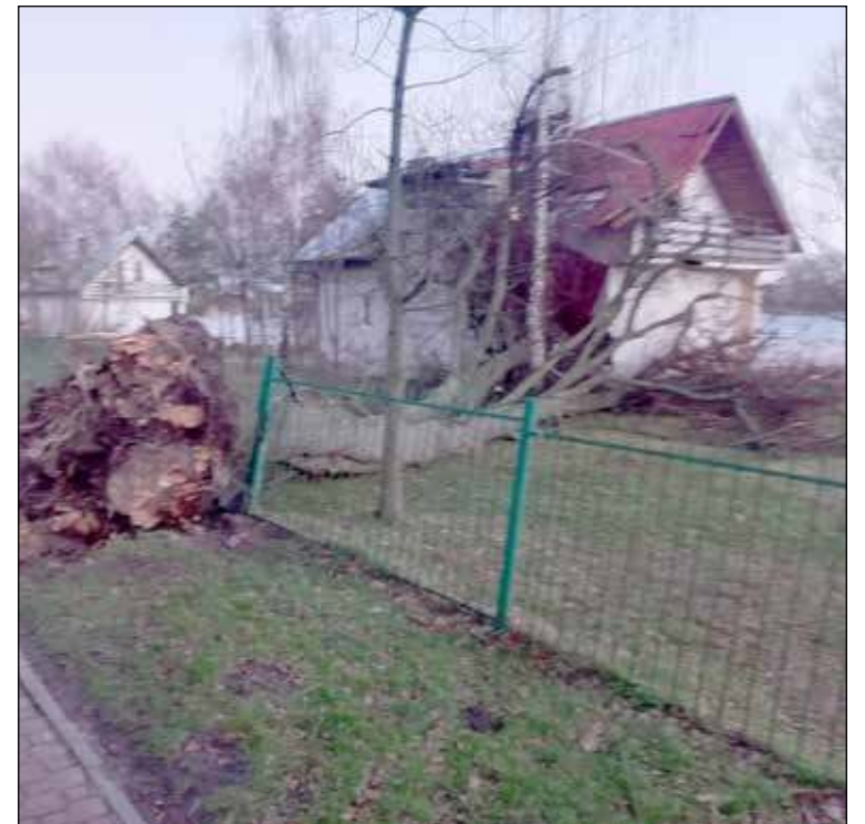
Uszkodzony przez wichurę domek
