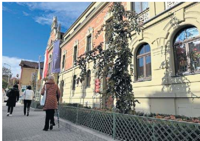
Zabytkowa część siedziby starostwa stanie się bardziej przyjazna, będzie winda, szersze drzwi i inne udogodnienia
