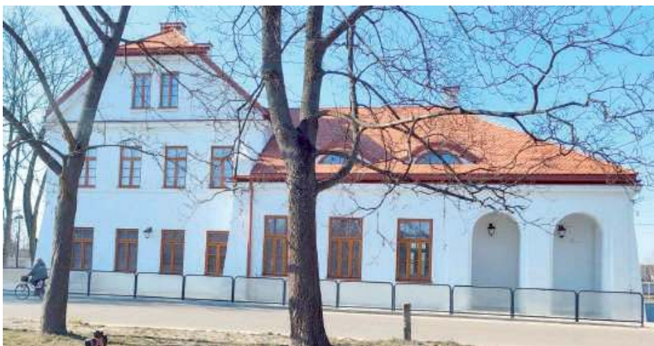
W latach 2020 - 2021 gmina wymieniła w budynku dworca pokrycie dachowe, okna i drzwi, posadzki i tynki
