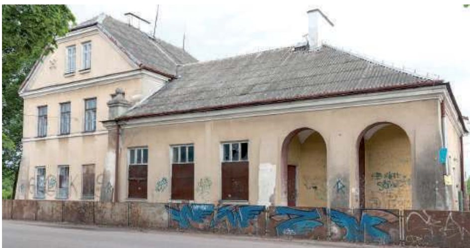
Dworzec w Krzywdzie przed remontem w 2017 r. (fot. Przemysław Król)
