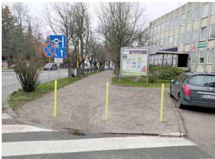
Zamontowane w tym miejscu słupki mają uniemożliwić parkowanie na chodniku
