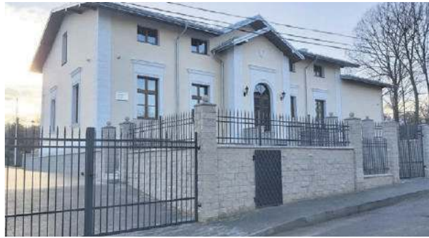
Budynek harcówki po zakończeniu prac. Fot. UM w Szczebreszynie
