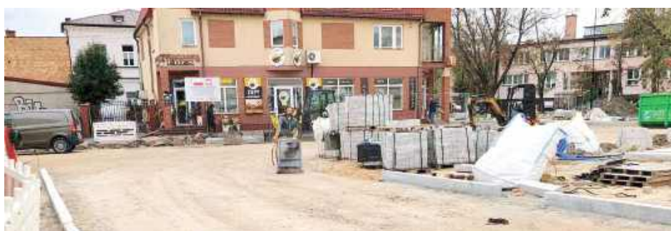
Przedsiębiorcy prowadzący działalność w bezpośrednim sąsiedztwie Placu Narutowicza skarżą się na bardzo trudną sytuację, jaka ich spotyka w związku z prowadzonymi w tym rejonie pracami budowlanymi
