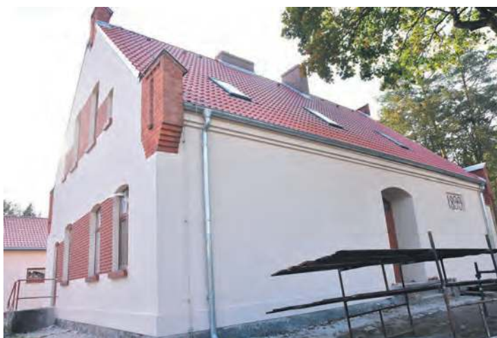
Budynek szkoły – zdecydowano się na przykrycie starej cegły tynkiem. Na rogach pozostawiono oryginalne wykończenia.
