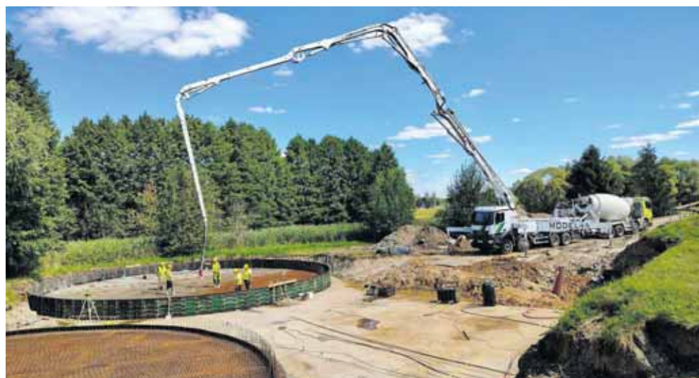
W minioną środę rozpoczęło się wylewanie płyt stanowiących dno reaktorów biologicznych
